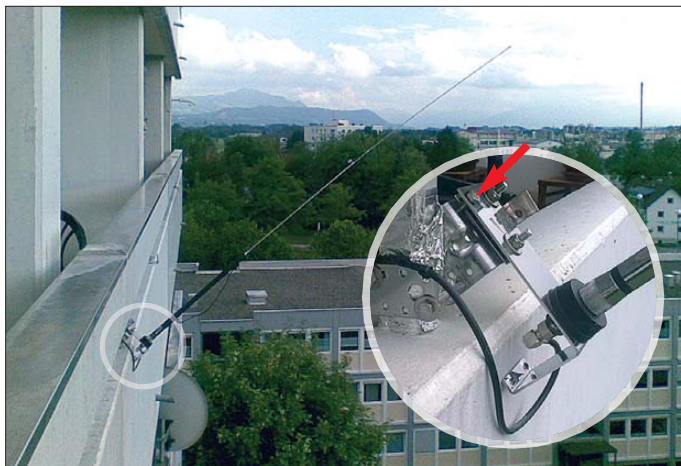
Bild 1: Ansicht der aufgestellten Antenne mit der vergrößert dargestellten Halterung und der Feststellschraube daran
