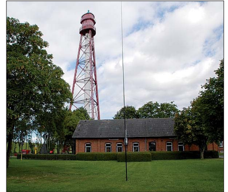
Der 65 m hohe Leuchtturm mit seiner zugehörigen Infrastruktur in Campen; im Vordergrund ist die Vertikalantenne für 40 m zu sehen. Fotos: A07
